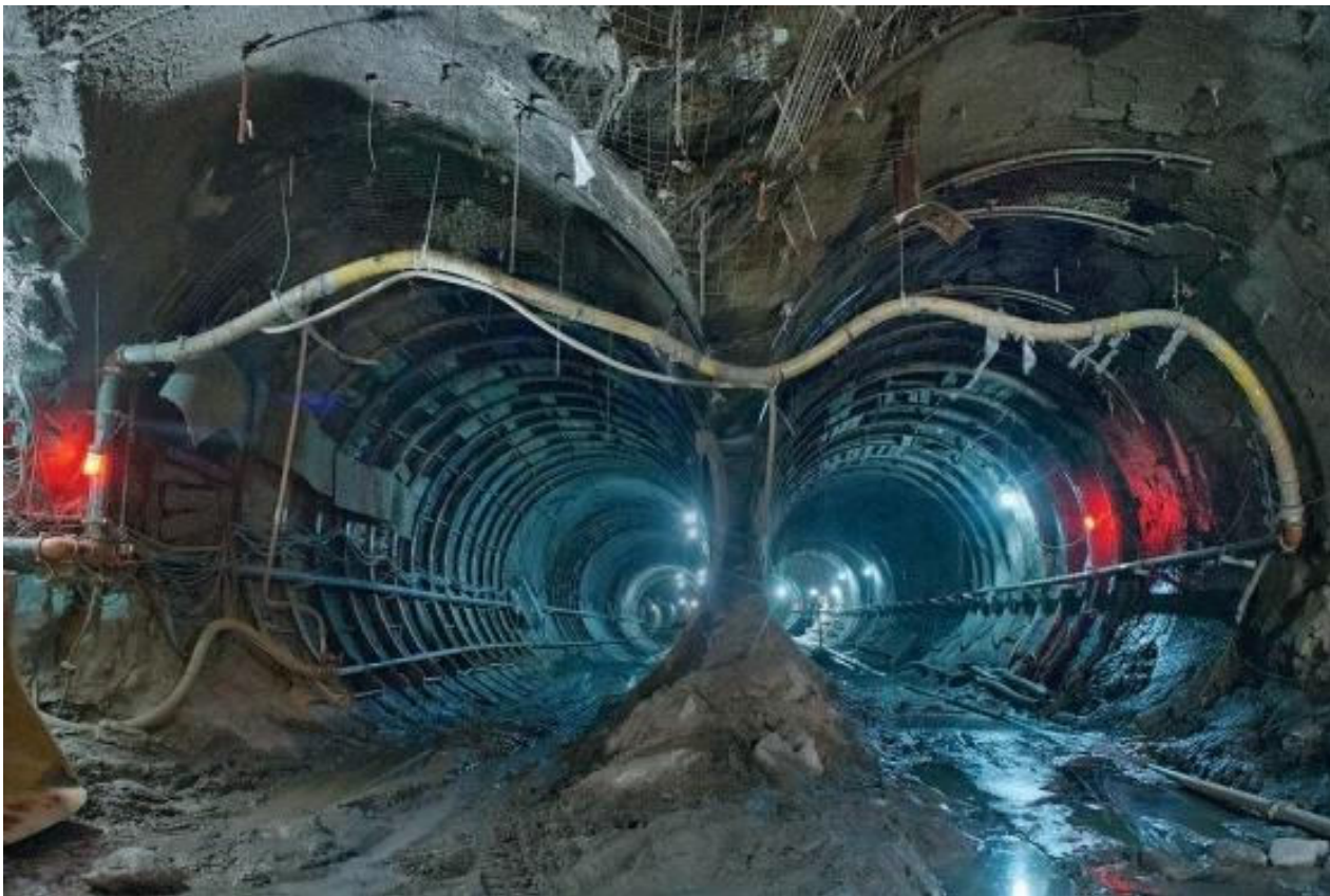
Строительство тоннеля закрытым (подземным способом)
