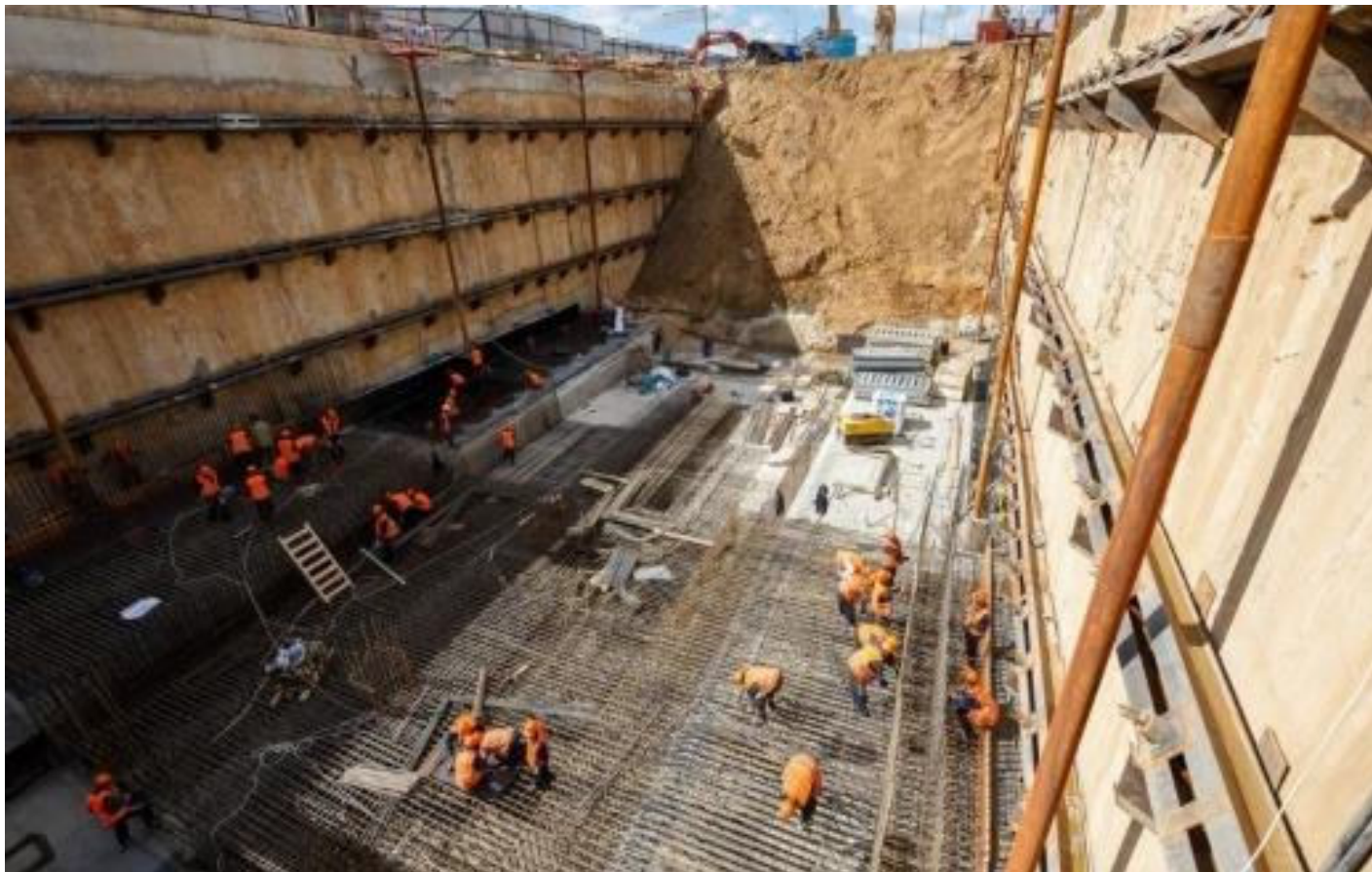
Строительство тоннеля открытым способом
